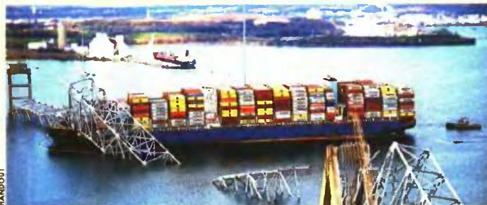
Η κατάρρευση της γέφυρας στη Βαλτιμόρη μετά την πρόσκρουση του «Dali», ενός φορτηγού πλοίου μεταφοράς εμπορευματοκιβωτίων, μεταφορικής ικανότητας 9.962 «κουτιών»
